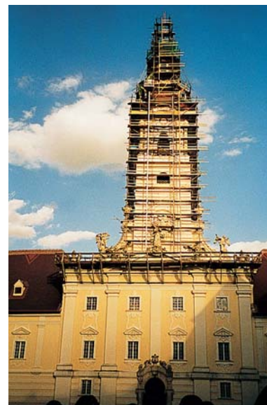
Altenburg, Stiftskirche, Turm während Restaurierung, Okt. 2002
